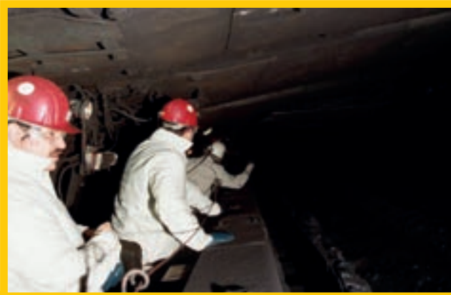
Direkt an der Abbruchkante
